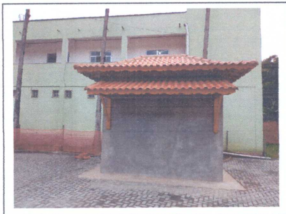
Reboco e telhado
