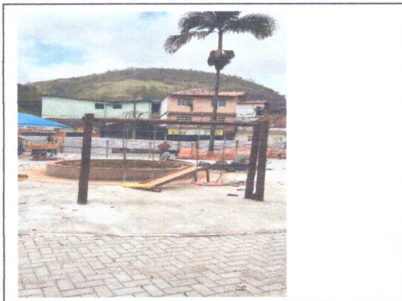
Instalação do parquinho
