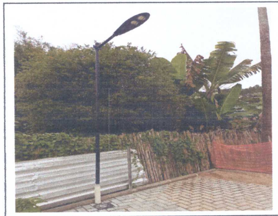
Instalação de postes com luminárias de led
