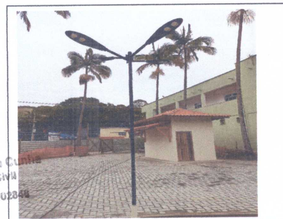
Instalação de postes com luminárias de led
