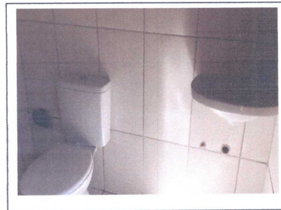
Instalação de vaso sanitário e lavatório
