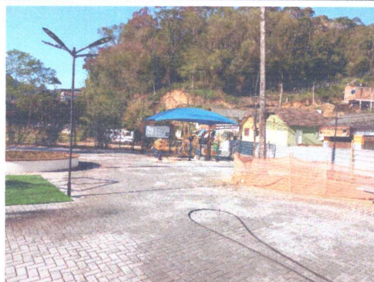
Assentamento de intertravado
