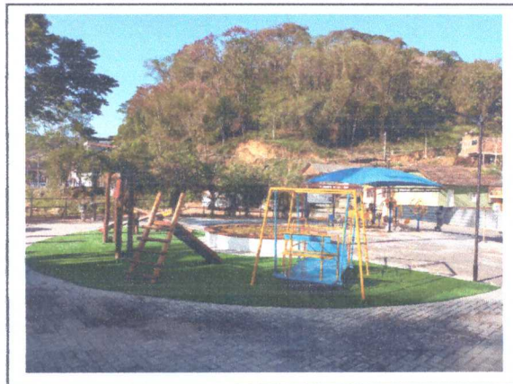
Instalação do parquinho (PCD)
