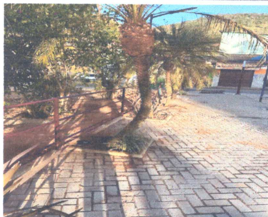
Instalação e pintura de guarda corpo
