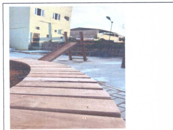
Assento de madeira no entorno do canteiro
